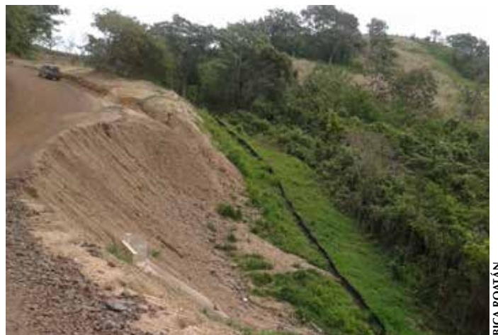
Arrastre de sedimentos por apertura de carreteras
