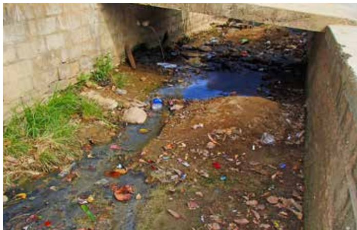
Quebrada contaminada con aguas residuales y basura
